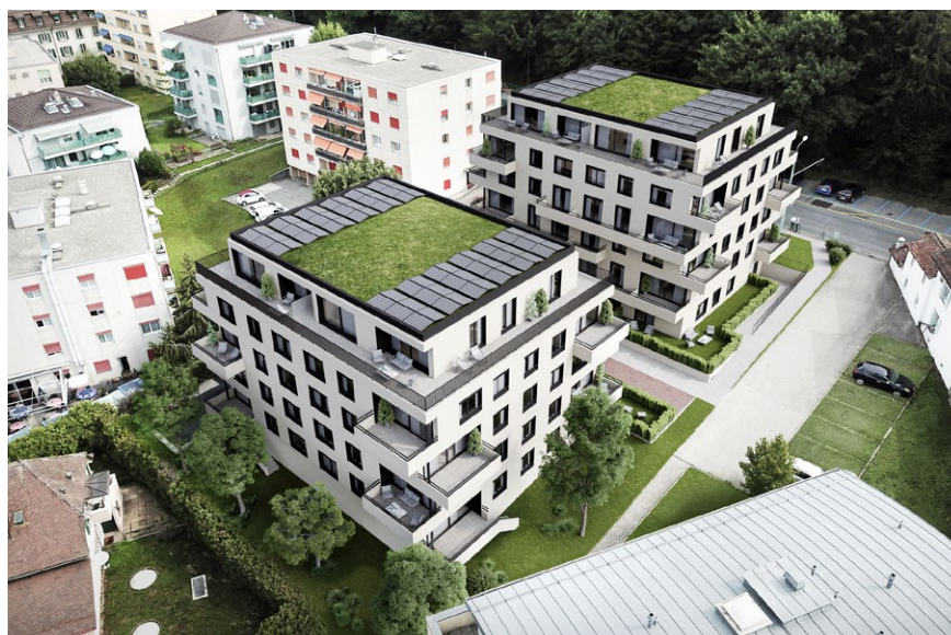
Visualisierung der zwei Mehrfamilienhäuser in Lausanne / © uni-architectes, Prilly
